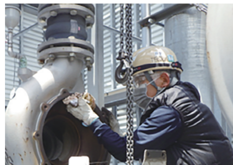
循環ポンプの整備
