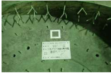
1 系プラズマ分解炉炉蓋(耐火物下鉄皮)
