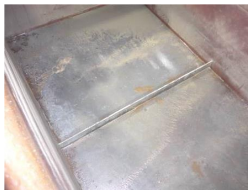
写真 3 シャワーリング後
