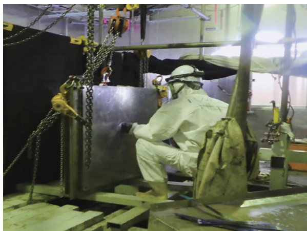
設備の解体・切断状況
