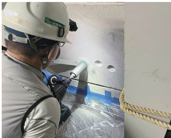
壁材の試料採取の状況
