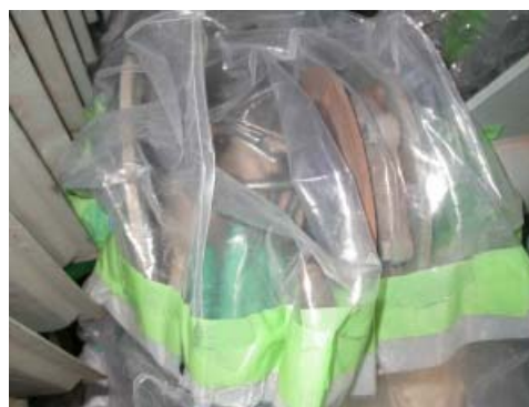
図7-2 グローブバッグを使用した付属品取外し作業
