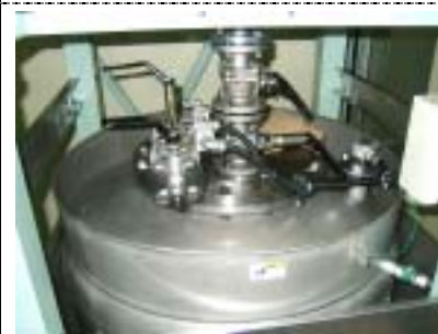
写真-3：専用容器上部 除染後
