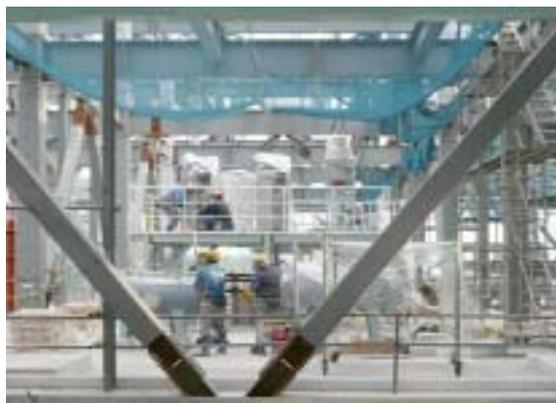
プラント機器(2F 蒸気ボイラー)の据付状況
