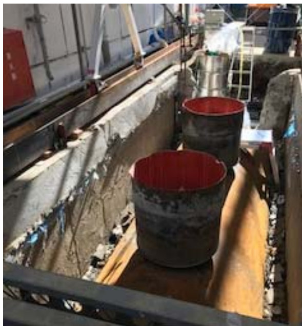
タンク掘出し
