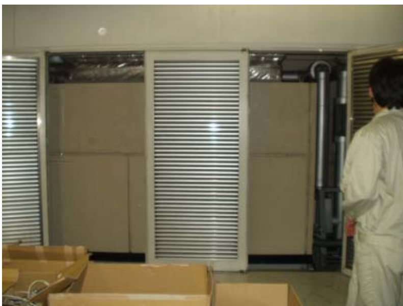
特高変電室から 見た空調室
