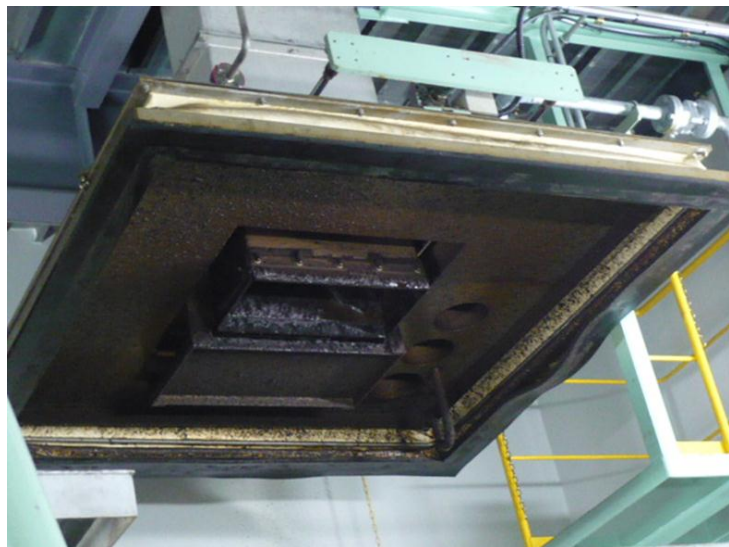
固形物充填槽の蓋 (中央部から固形物が充填され、 隣の3つの排気口から排気される)
