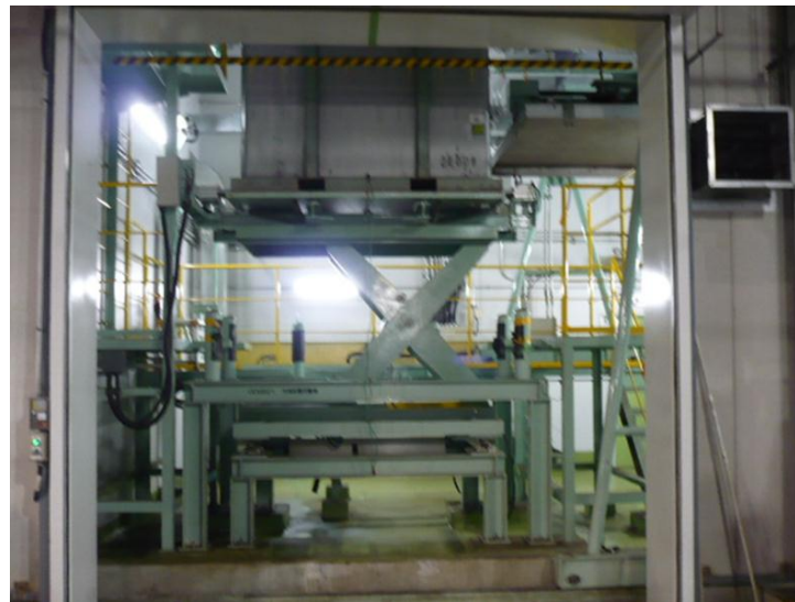
固形物充填槽が持ち上げられ、 蓋にセットされる様子 (手前が払出室)
