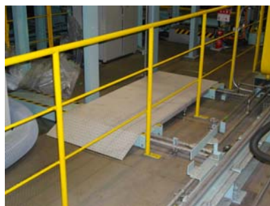
踏み板の設置後
