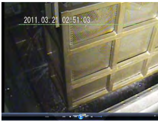
漏洩時の状況
