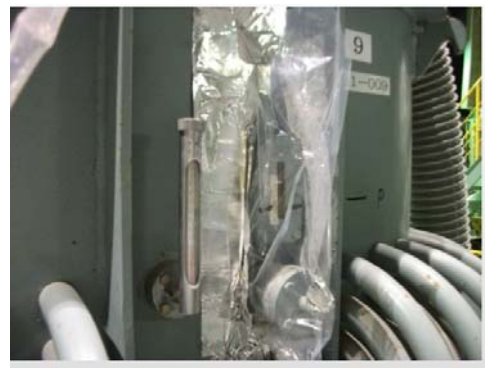
油面計の養生状況
