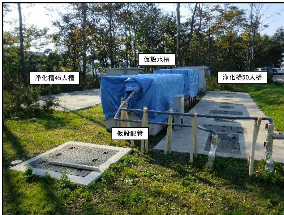
浄化槽及び仮設配管等の設置状況
