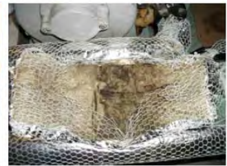
フレキシブルホース断熱材内部
