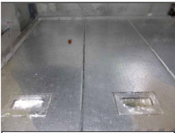
解体場槽の天板 (作業スペースから)
