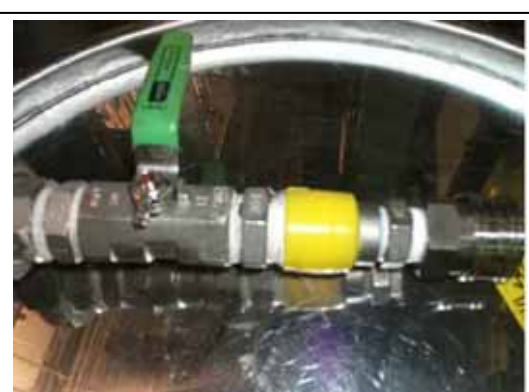
漏洩箇所状況(右は誤って外したカプラ)
