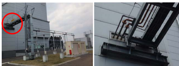
増設施設 鋼製カバー設置予定箇所
