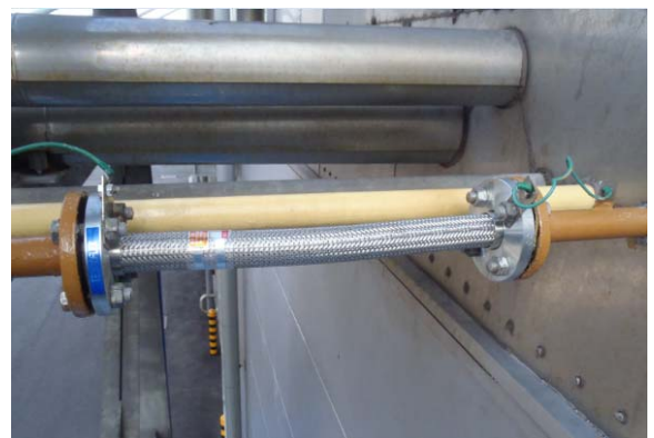
フレキシブルホース (交換後)
