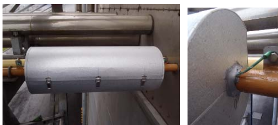
増設施設 鋼製カバー設置状況
