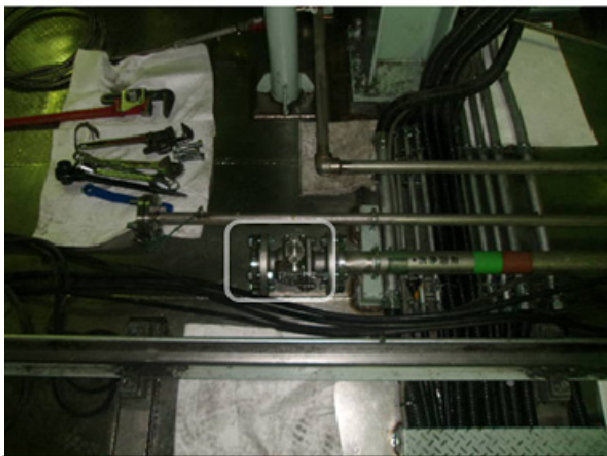
設置した閉止弁
