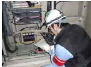
(解説)写真は、計装ループチェックの様子です。中央制御室と現場が無線連絡により、貯槽、蒸留塔、回転機、制御弁等に取り付けられた各種検出器を一つひとつ慎重に確認しているところです。
