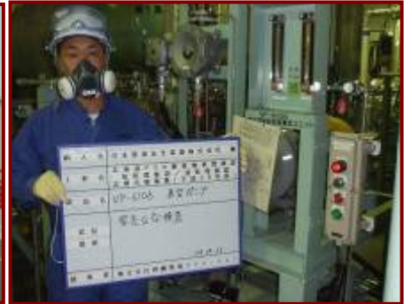
定期点検(H20.10.1~31)
