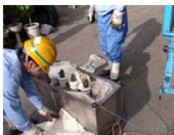
漏れ防止型金属 トレイ(SUS)に 収納 吸収材で隙間を ふさぐ
