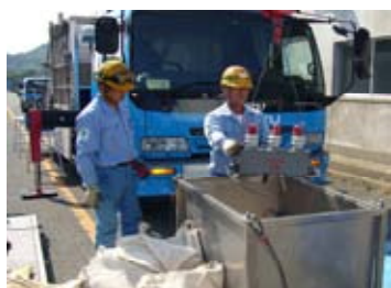
漏れ防止型金属トレイに収納 吸収材で隙間をふさぐ
