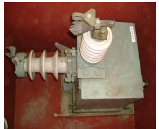
図9 計器用変圧器例
