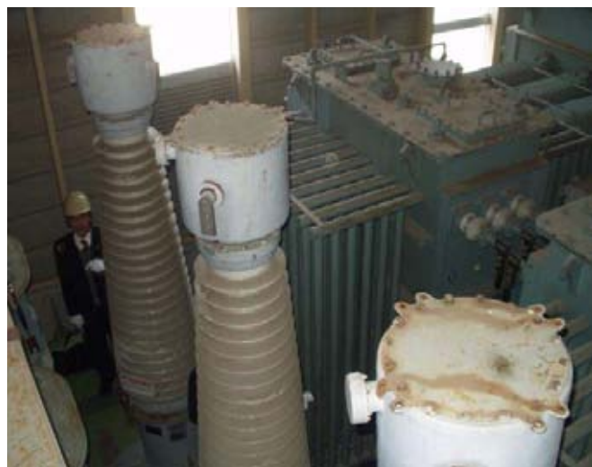
図 11 碍子型計器用変流器例
