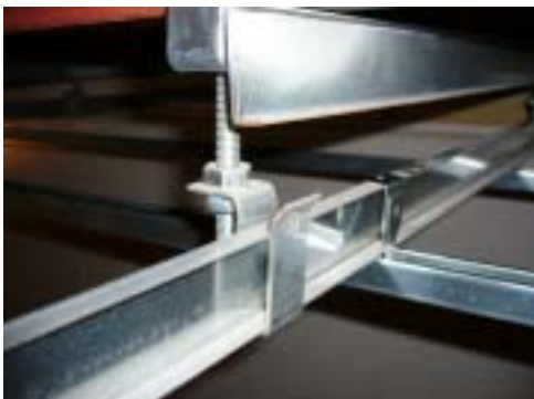
写真 4 クリップの施工写真(1)
