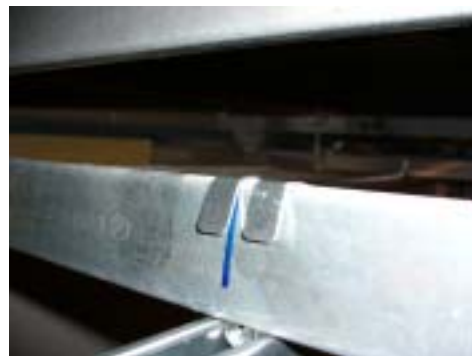
写真 - 5 クリップの施工写真(2)
