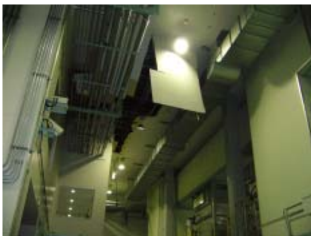
写真 - 1 天井材落下状況(天井部)
