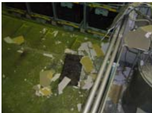
写真 - 6 床に落下した天井材
