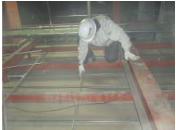
写真-2 破碎室点検状況
