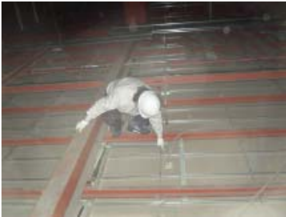
写真-1 二次洗浄室点検状況
