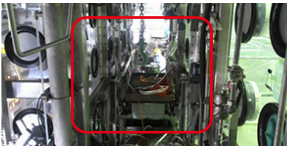
内部機器撤去前
