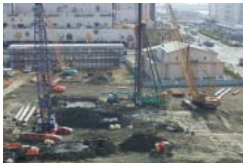
騒音・振動に配慮した埋め込み杭による東区画杭工事
