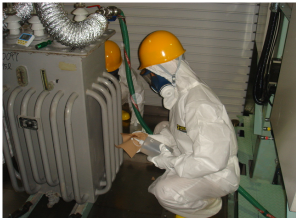
漏洩想定現場の除染作業
