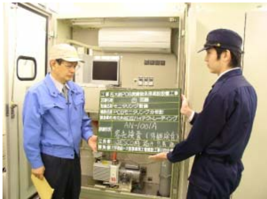
工場立会検査の様子
