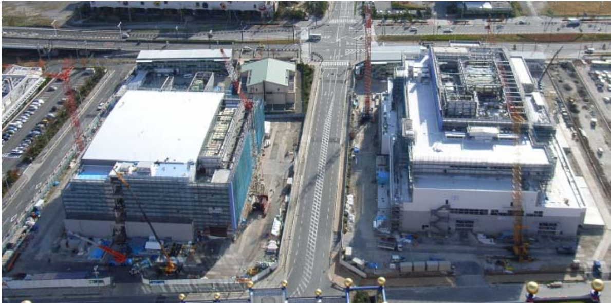
11月23日時点の建設状況（写真左：東区画、右：西区画）
