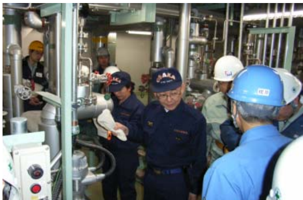
消防局・此花消防署による完成検査の様子
