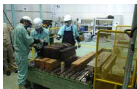
払出設備のトランスのコア処理(引渡性能試験) (真空加熱分離装置で処理済のコア切断)
