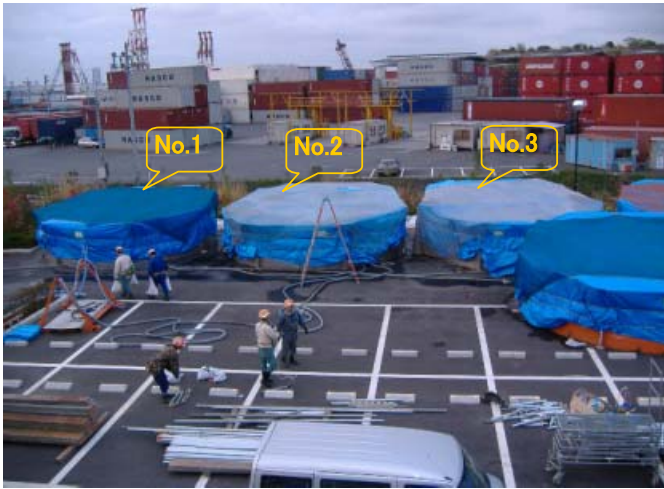
屋外仮設タンク撤去前
