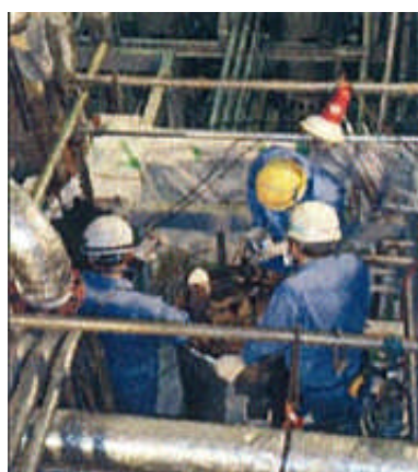
写真1 除去作業状況
