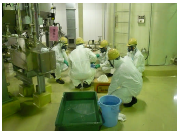
写真１４ 漏洩油回収作業
