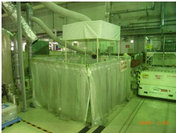
写真12 コア鉄心の手解体作業場所
