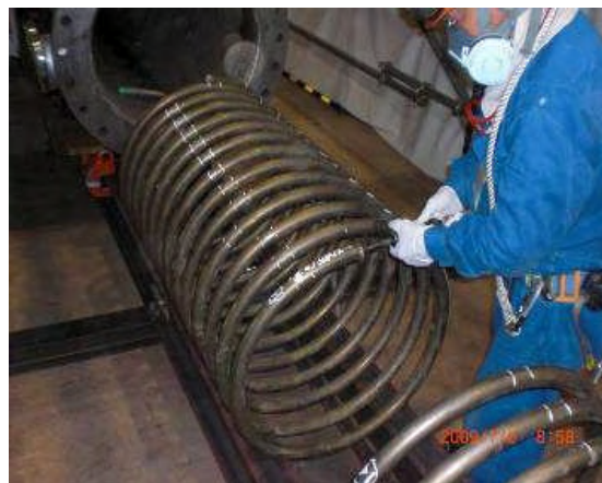
写真 4 冷却コイルのスケール除去作業
