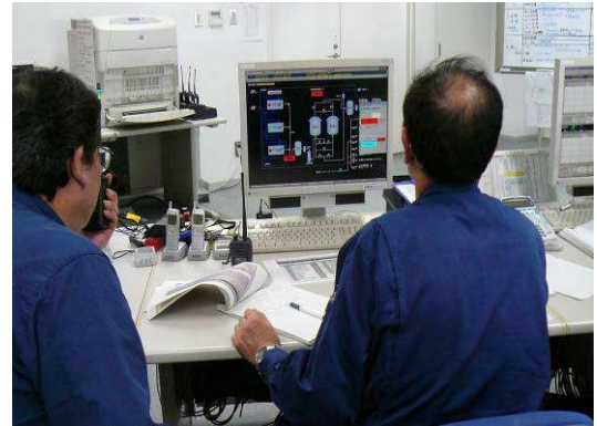
写真6 停電復旧後の立上操作 (H21.12.4)
