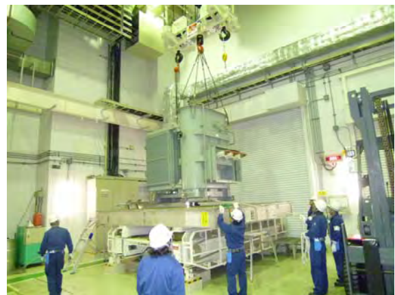
写真 1 0 搬入状況(受入室作業)
