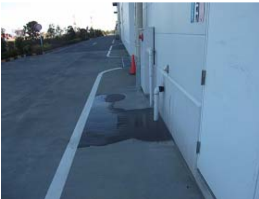
消火水配管の水漏れ
