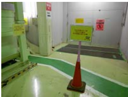
写真5 通路の改善状況
