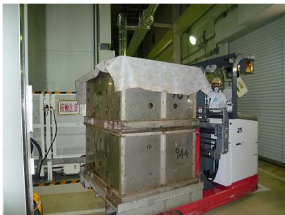
写真2 コンデンサ容器運搬・オイルパン保管状況
