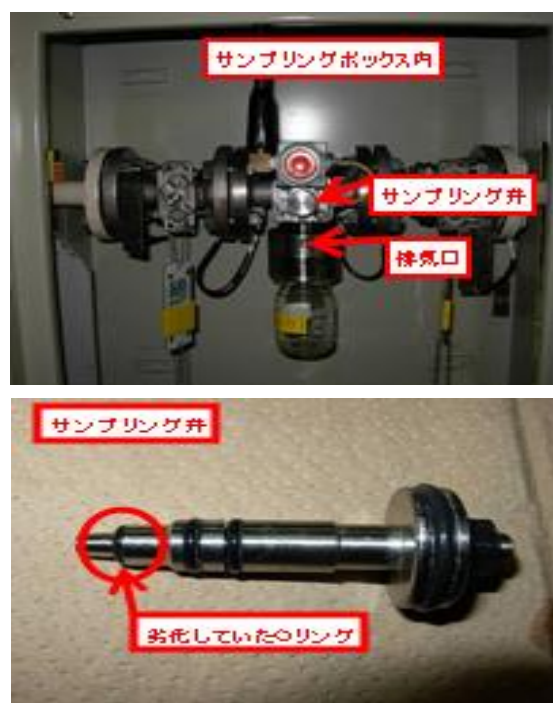
写真4 サンプリング装置(上) サンプリング弁(下)
