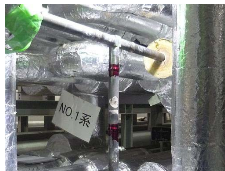
写真2 補修後（PT 試験実施）
