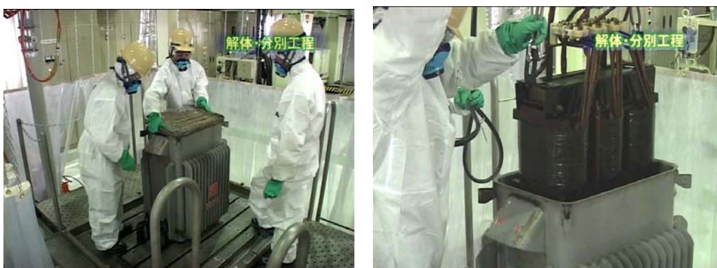
図2 JESCO 東京事業所におけるトランスの解体作業
