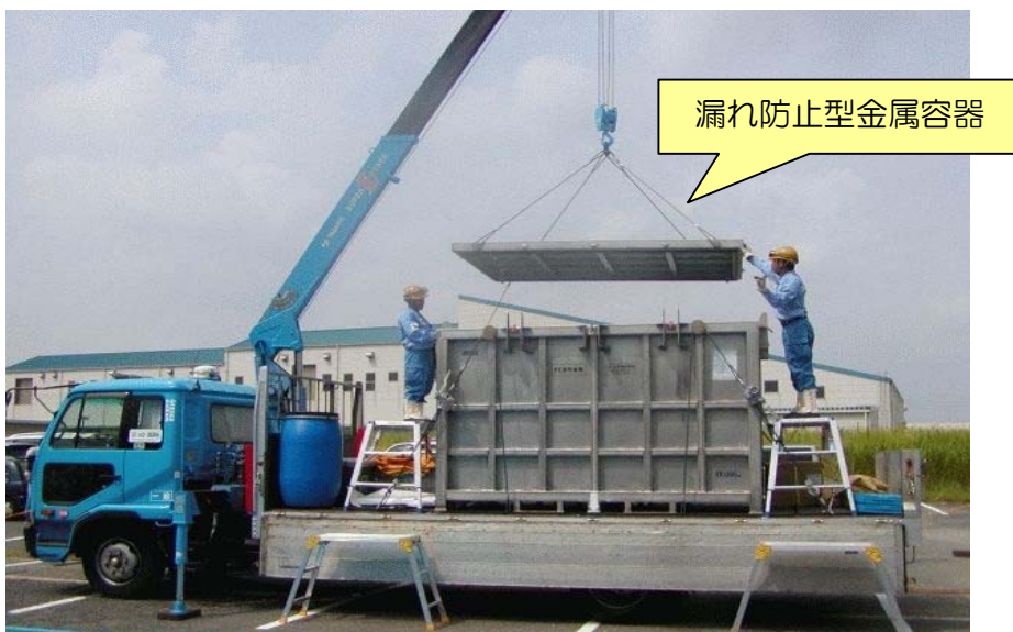
漏れ防止型金属容器の蓋載せ
