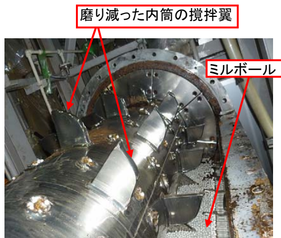
改善工事前のUFミル装置
