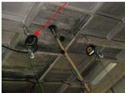
②硫酸受入時にタンクベント配管から硫酸ミストが周辺に飛散する。(体験)
