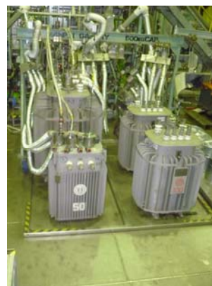
トランスの抜油・粗洗浄 （小型ステーション）
