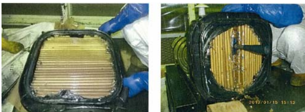
手解体の様子
