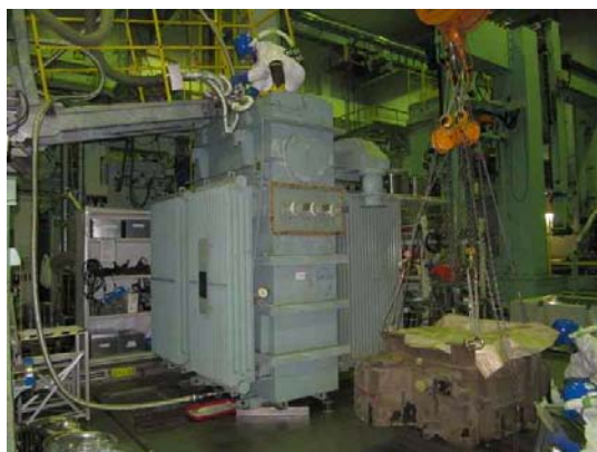
トランスの抜油・粗洗浄 （大型ステーション）
