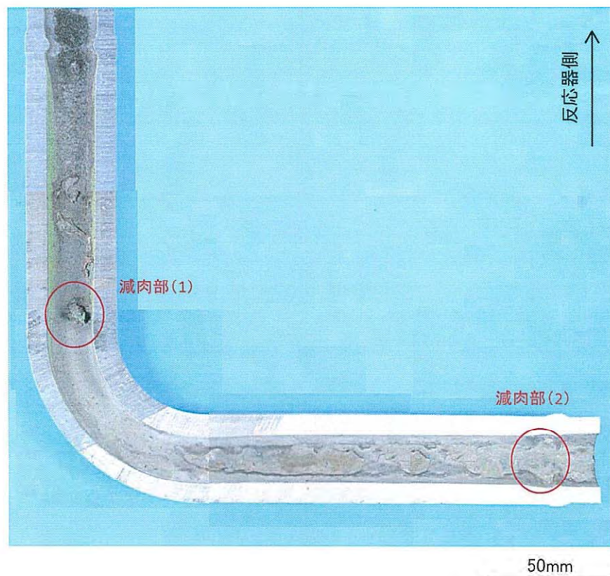
図13 スラリ投入管台地側内面状況
