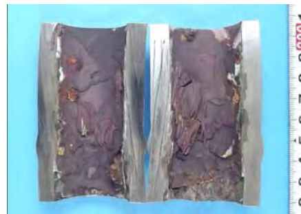
管内のスケール
