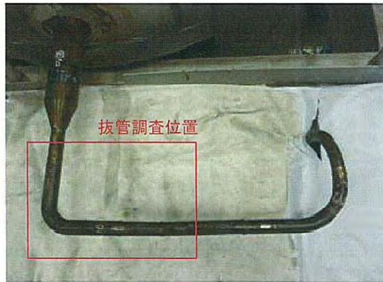
図6 抜管調査位置
