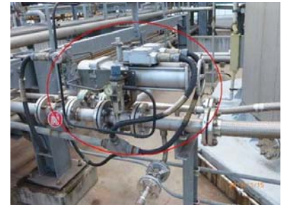
処理済油槽遮断弁
