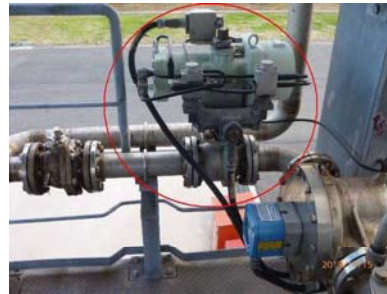
出荷設備遮断弁
