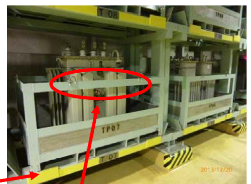
転倒防止柵設置(トランス)
