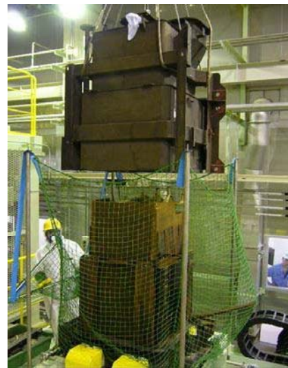
内部部材の取り出しの様子
