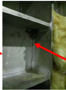
蒸気ジャケット 溶接部
