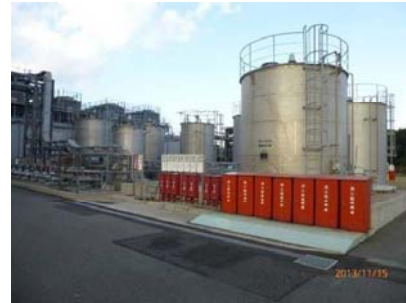
屋外貯槽類について設置した遮断弁等(例)
