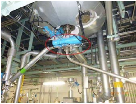
液処理反応槽
