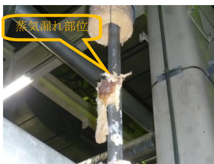
図9 水熱分解設備配管蒸気漏れ箇所
