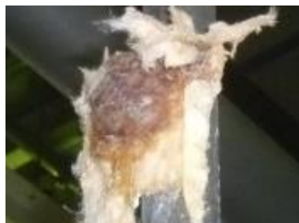
図10 水熱分解設備配管蒸気漏れ箇所拡大
