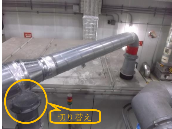
図15 排気系統をコンデンサGB系統へ変更
