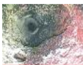
図11 蒸気漏れ箇所 付近管内面
