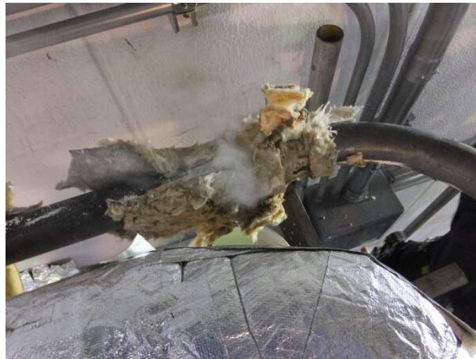
図6 蒸気漏れ状況
