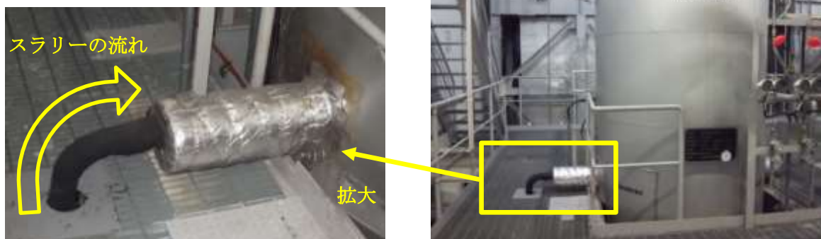
写真-2 水熱反応器入口のスラリー配管(新設)
