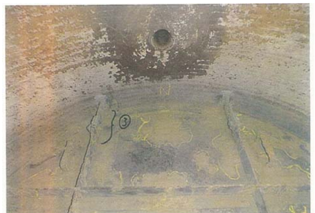
図－５ No.1 水熱分解設備下部隔壁の外観写真
