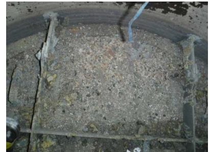
図-7 No.1 下部隔壁上部の堆積物の外観
